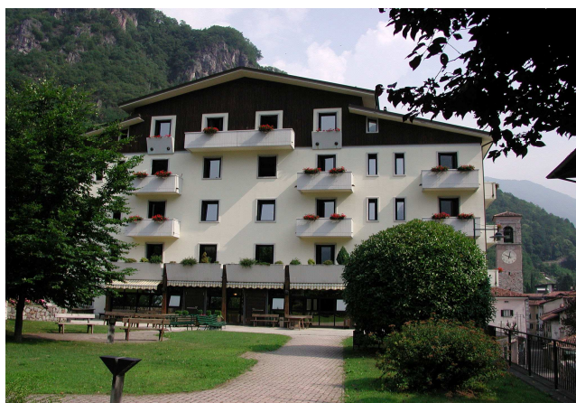
Immagine attuale edificio Blocco B
