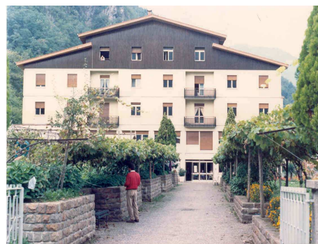
Edificio “Blocco B” anni 80
